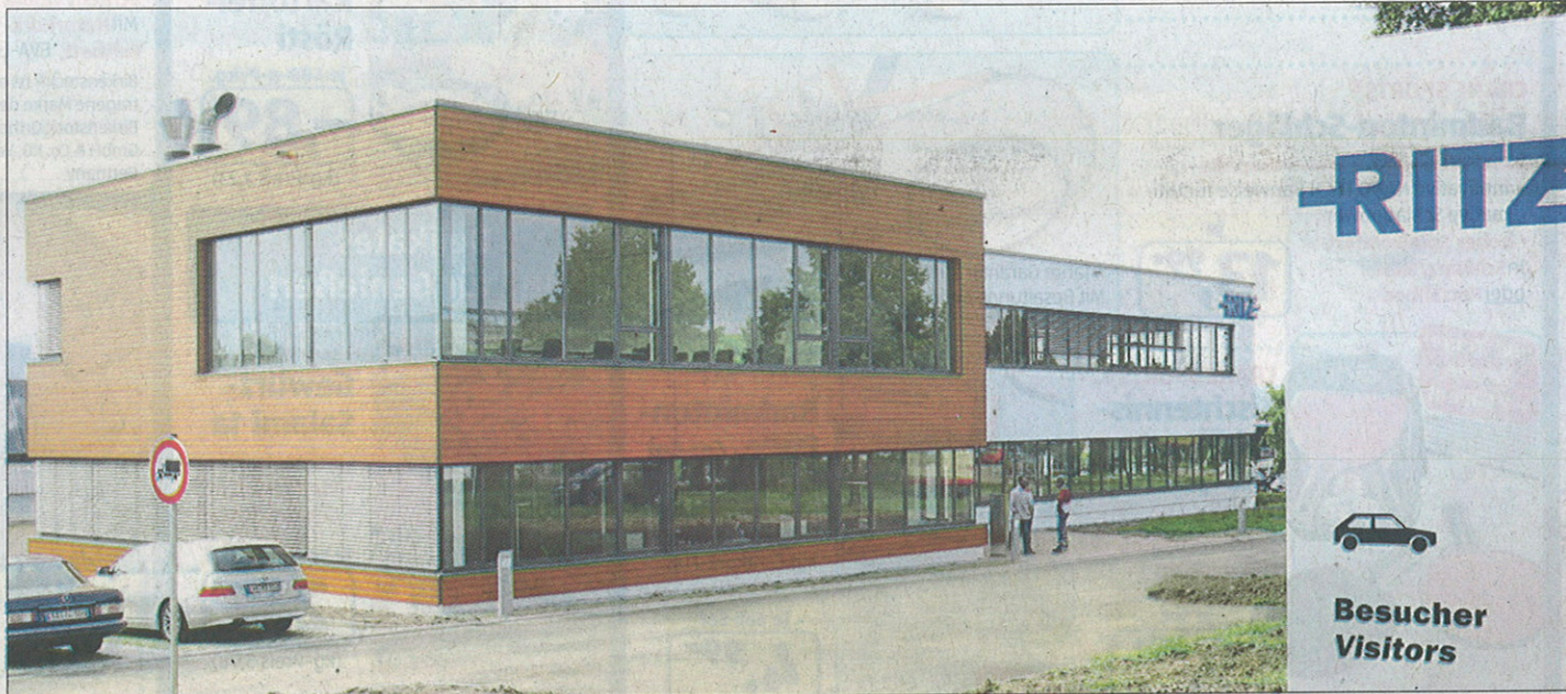
Neues Design und neue Öffnung hin zur Güglingstraße: So empfängt die Firma Ritz Pumpen jetzt ihre Kunden und die Gäste des Unternehmens. (Fotos: Tom)
